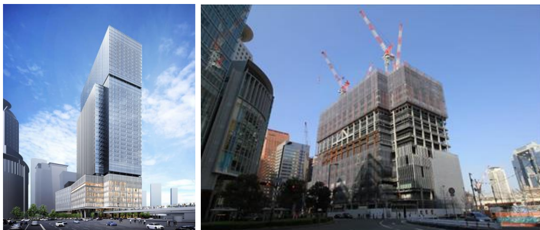
左：外観イメージ（JR大阪駅前から）、右：建設工事の様子（2022年3月16日時点）
