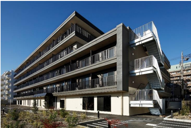
建物外観（北東側から）
