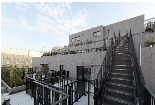
建物外観(北側から)
