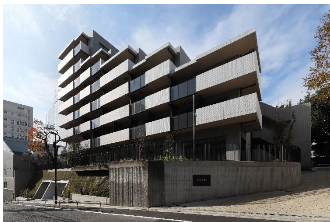
建物外観(北東側から)
