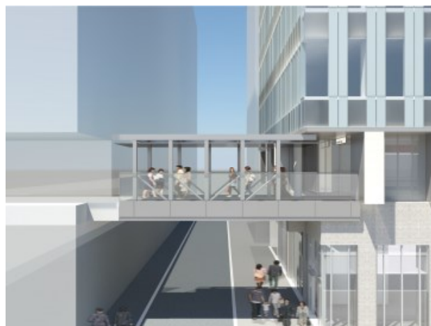
市道7号線上空接続通路
