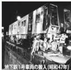
地下鉄1号車両の搬入(昭和47年)
