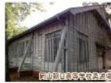
岡山朝日高等学校柔道場
