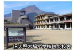
旧大野木場小学校被災校舎
