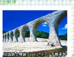
旧国鉄士幌線コンクリートアーチ橋梁群
